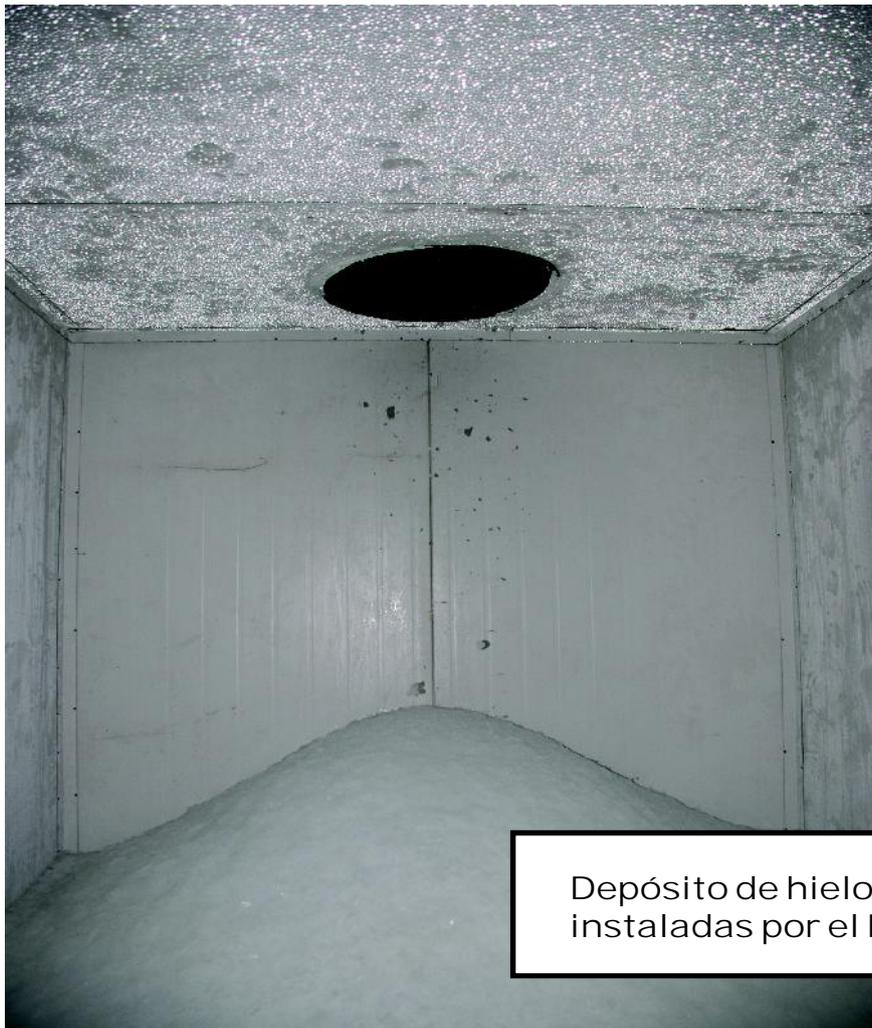
Depósito de hielo en una de la fábricas instaladas por el Proyecto
